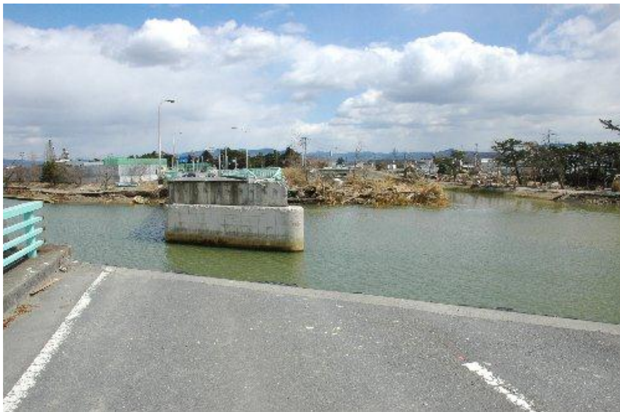
流された船の衝突で落下した県道の橋
