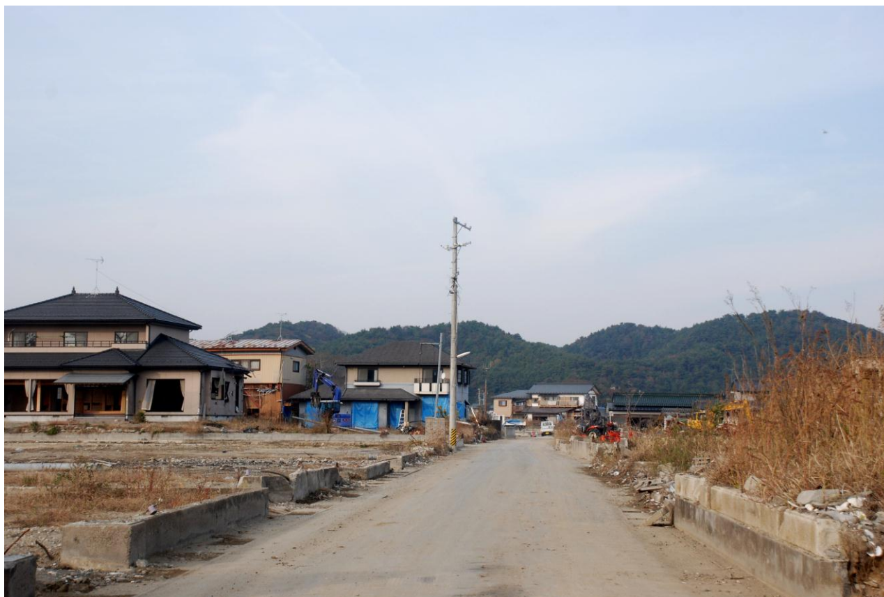
多くの住宅が倒壊・撤去された
