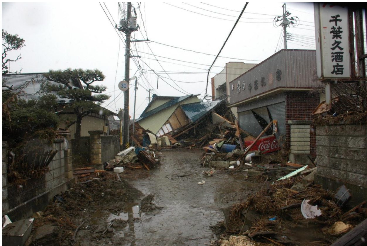
道路に流出した住宅
