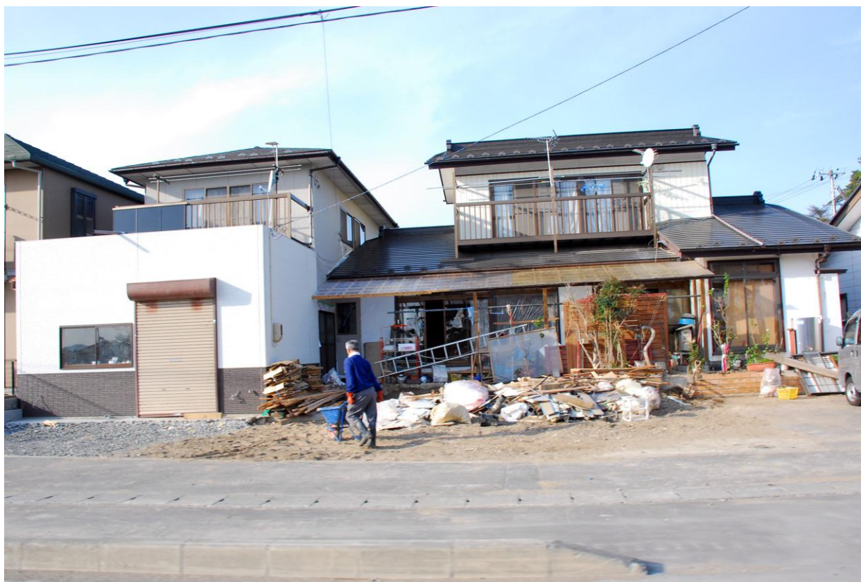
瓦礫が撤去され自宅を修復する住民(亀岡)
