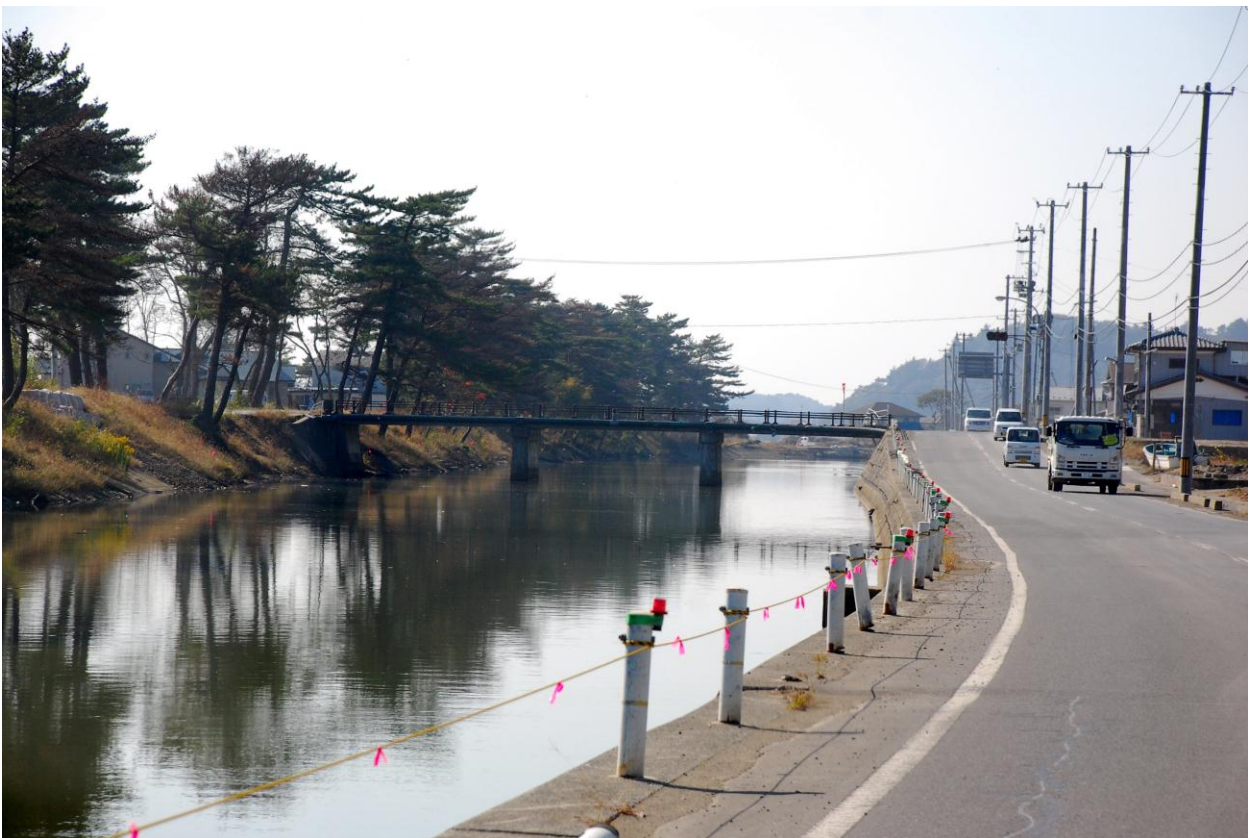
家屋と瓦礫が撤去された東名運河
