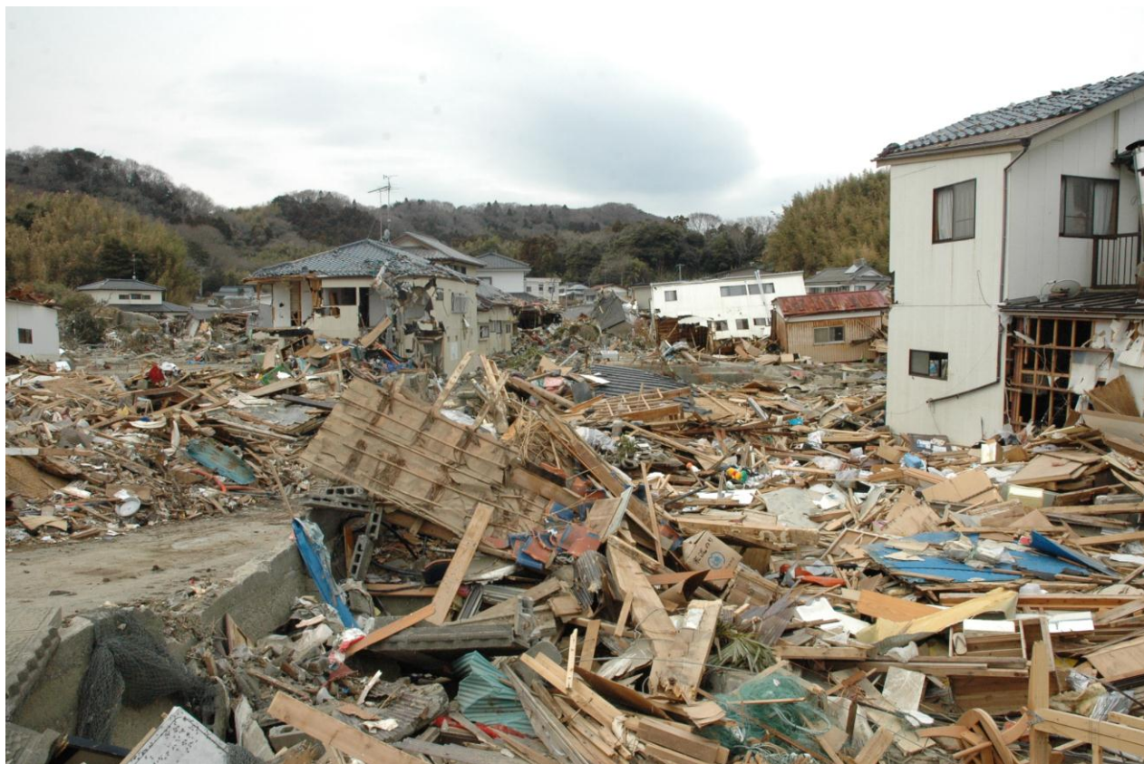
津波に破壊された多くの住宅(室浜)
