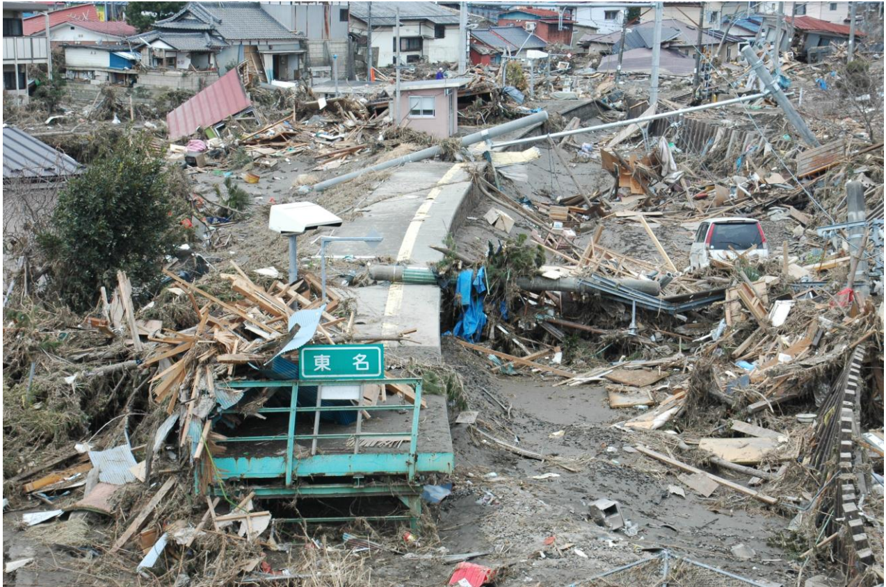
線路も流出した東名駅
