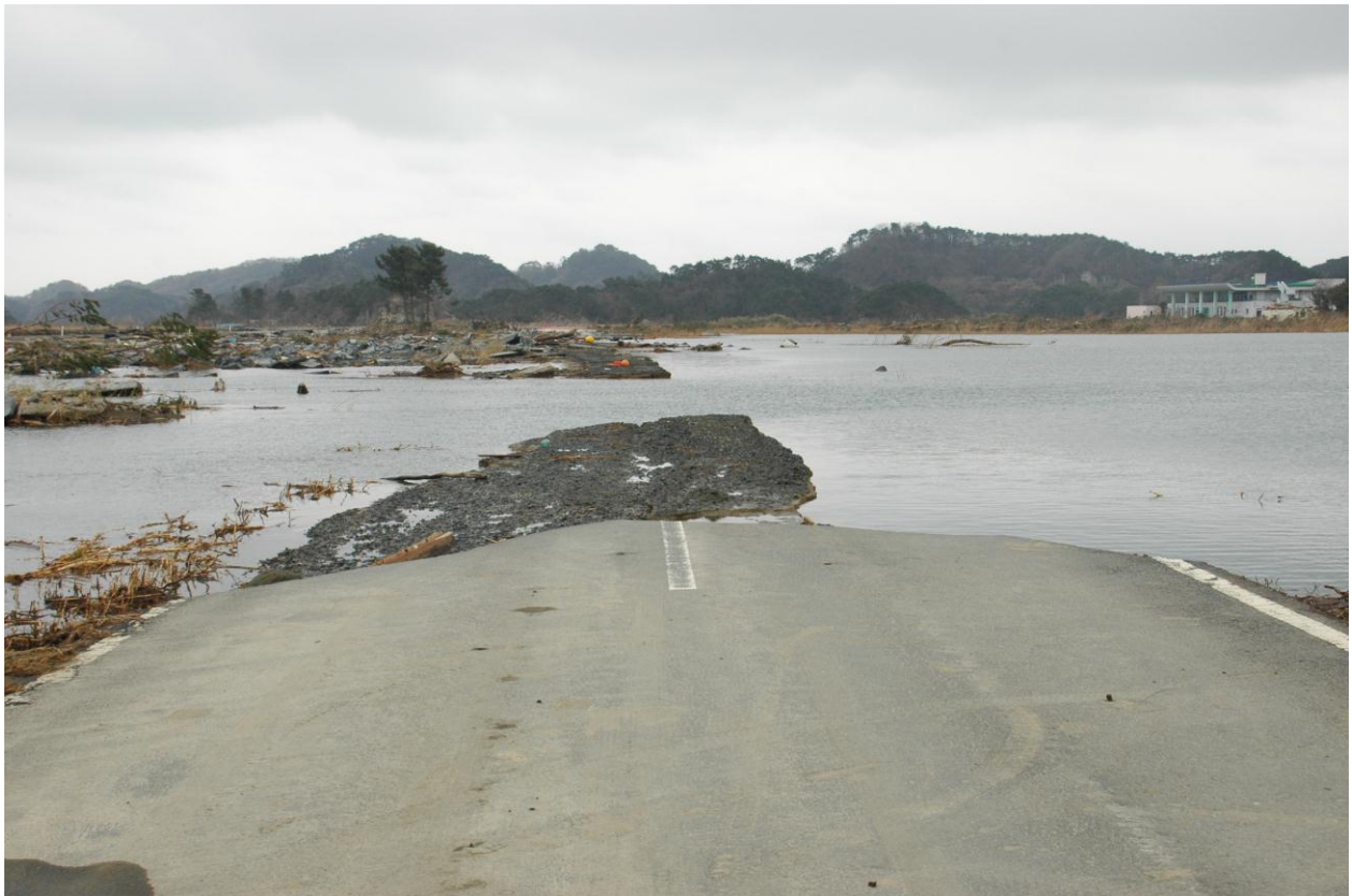
津波で断線された野蒜海岸線道路
