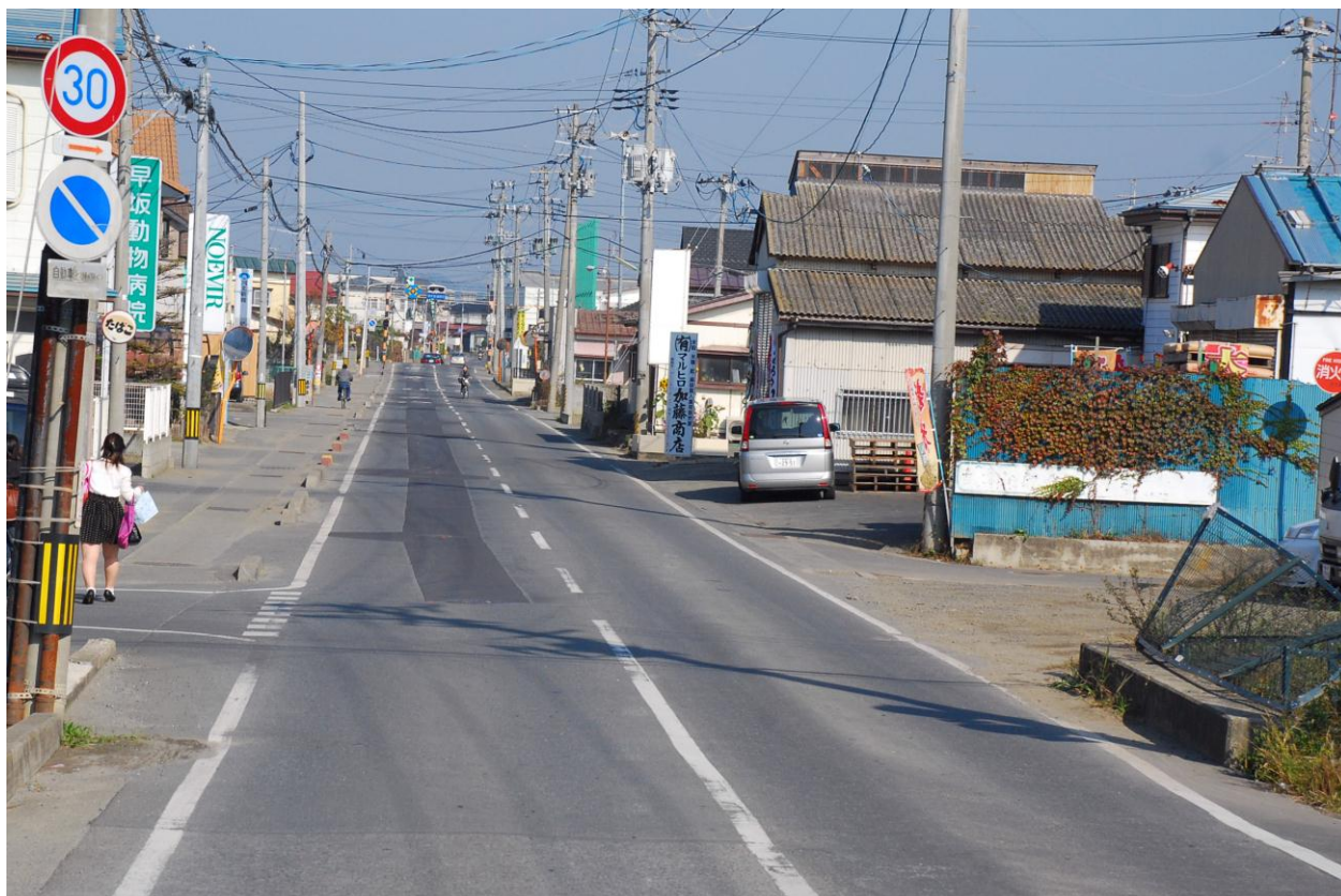
冠水し泥だらけだった道路も清掃された
