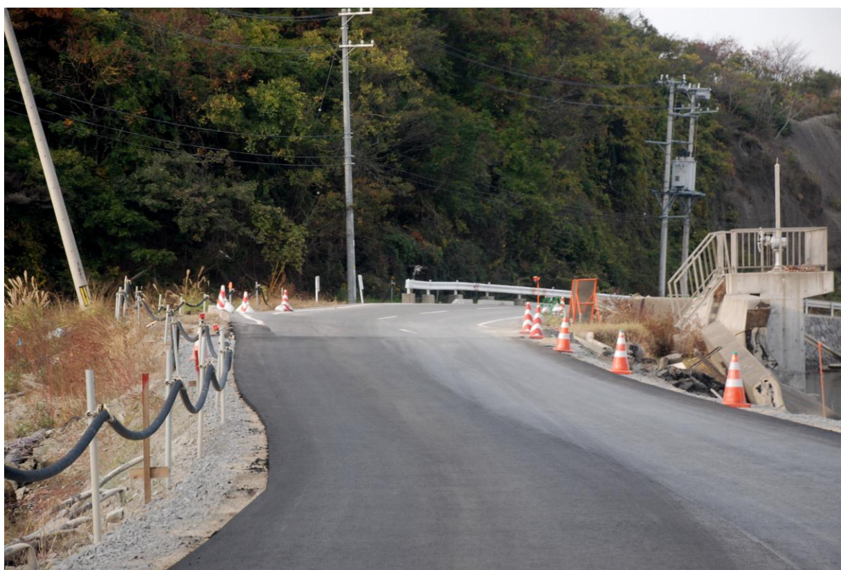
仮舗装され復旧した道路
