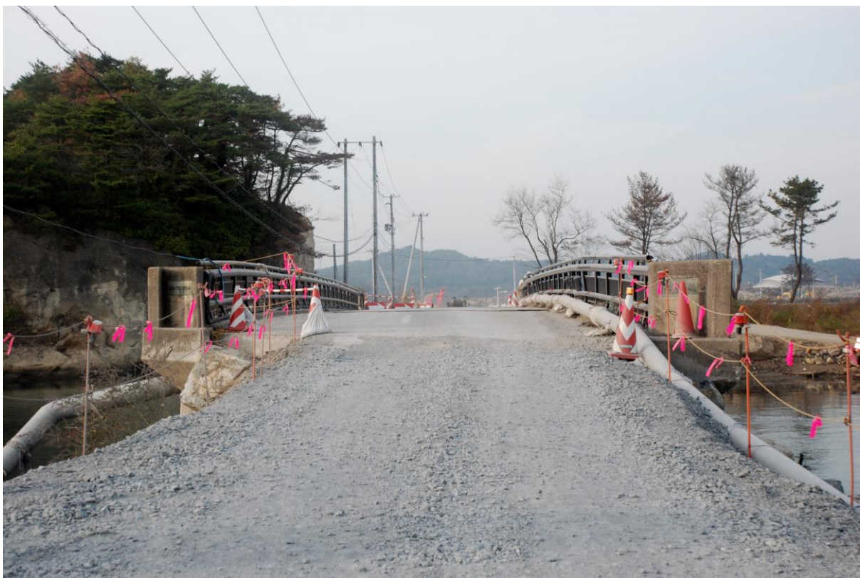
道路が復旧し、接続された松ヶ島橋
