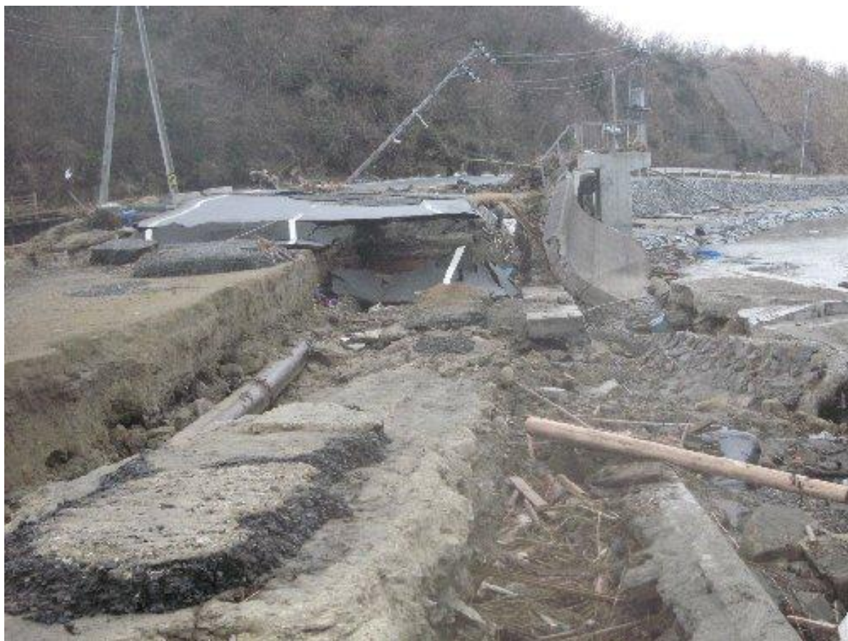
津波にえぐられた県道。水道管がむき出しに
