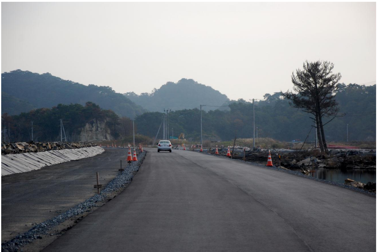
仮復旧し舗装された野蒜海岸線道路
