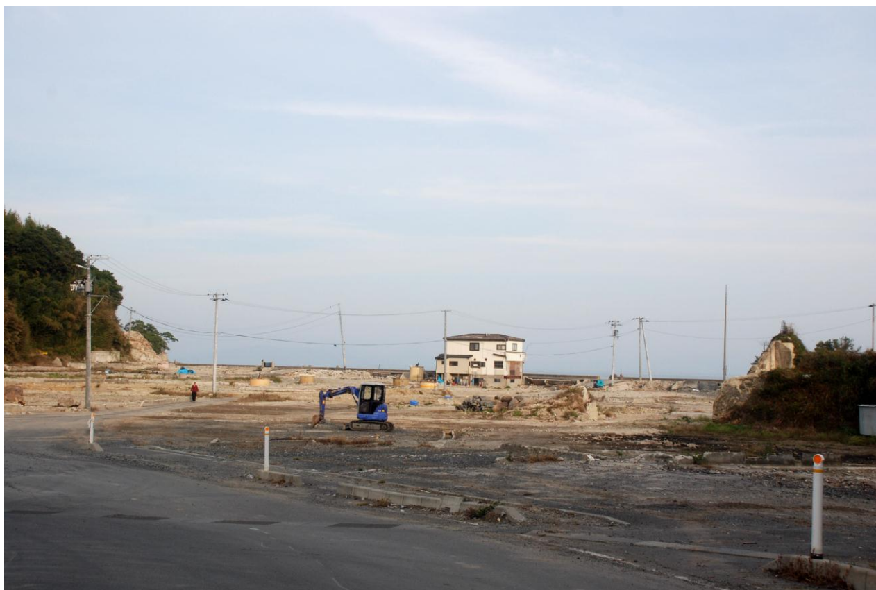
住宅や瓦礫が撤去され更地になった宅地(室浜)
