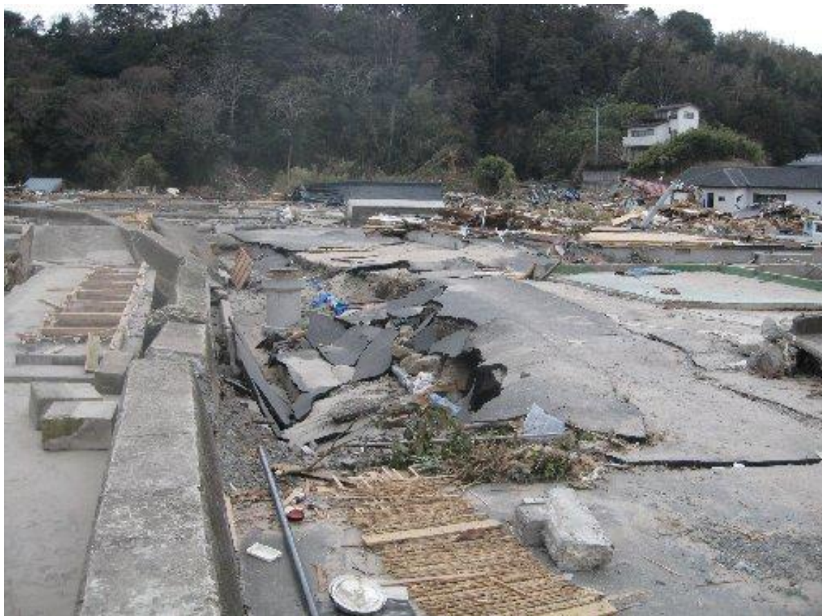
破壊された堤防・海岸線と住宅街(月浜)
