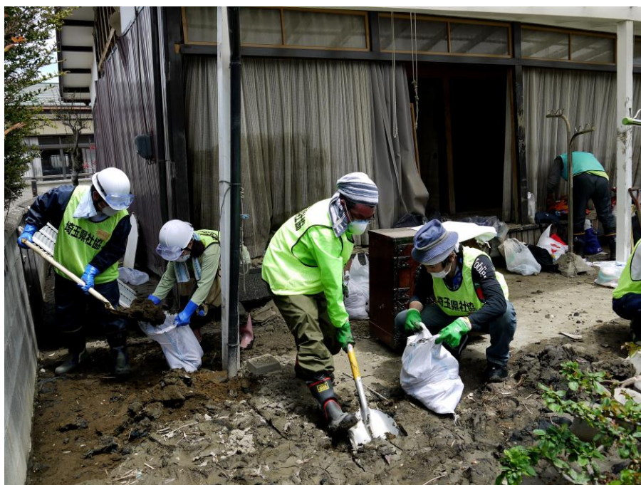
市内各所 住宅内の汚泥を撤去するボランティアの方々
