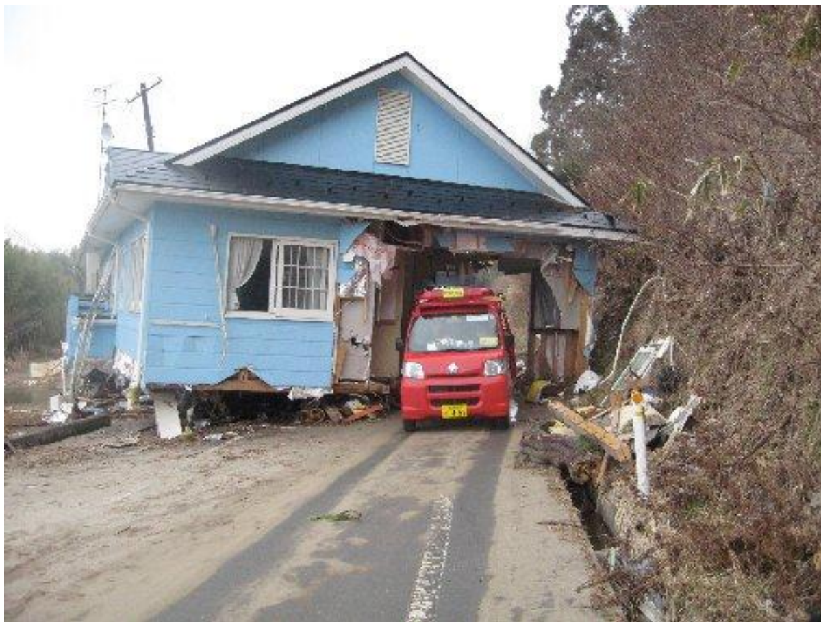
道路に流出した住宅
