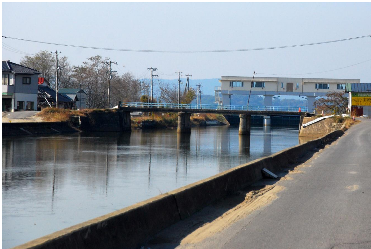
住宅や瓦礫が撤去された運河
