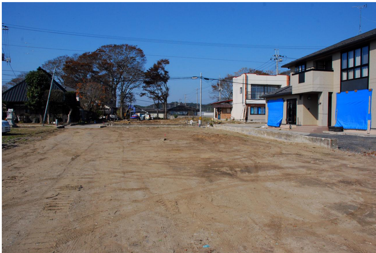
残った住宅は復旧が行われている
