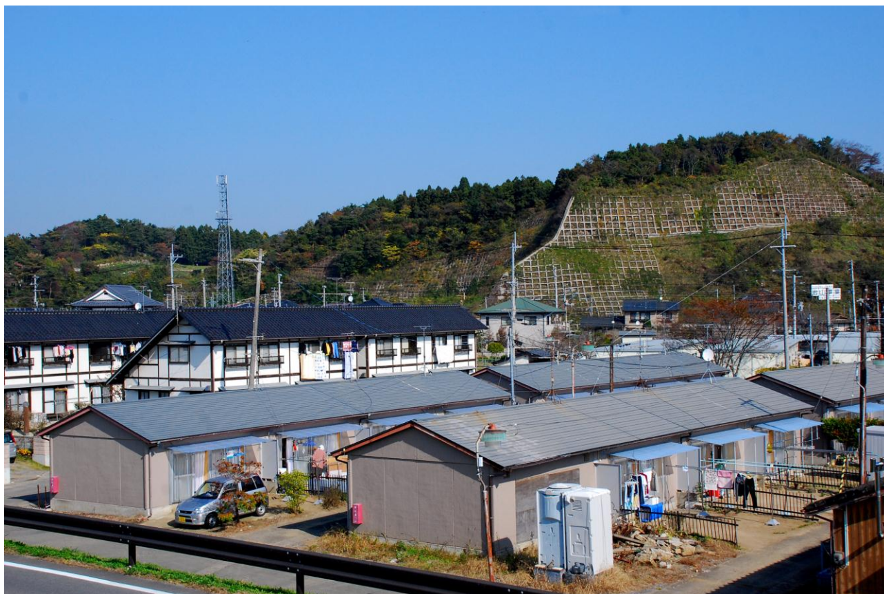
復旧した市営住宅
