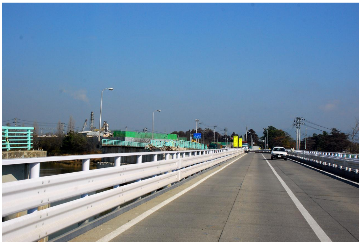
落下した県道の橋の隣に仮橋が整備
