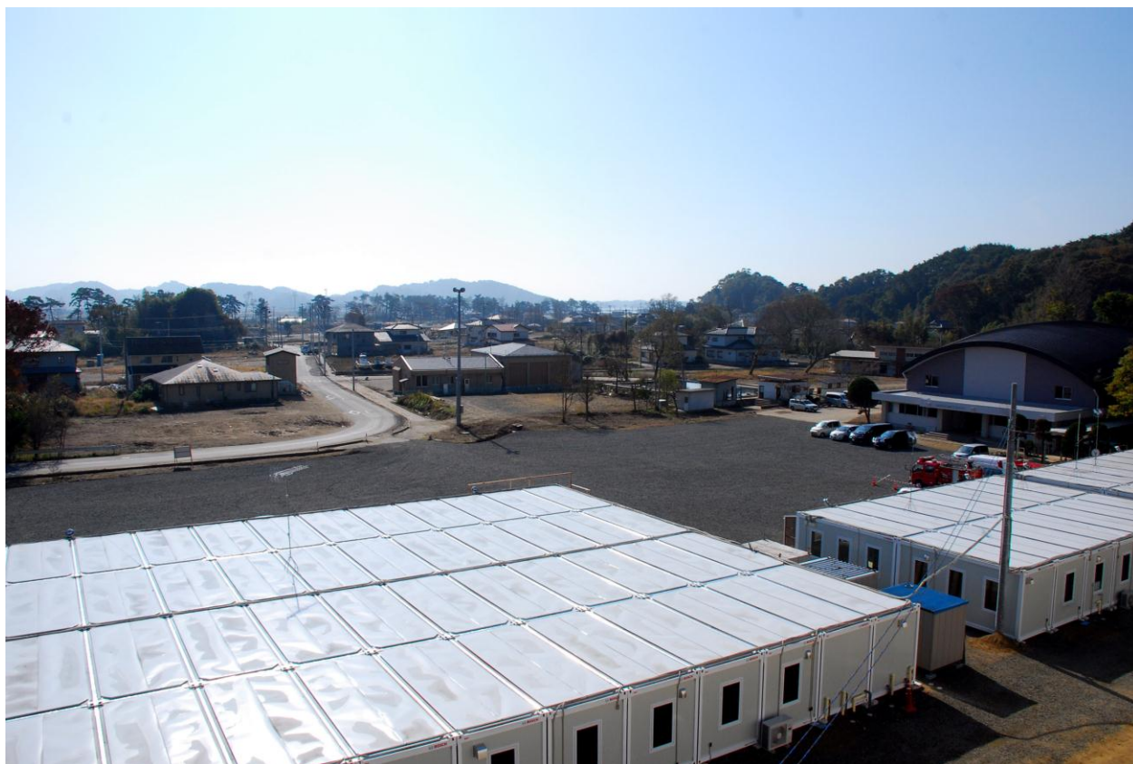
消防所や野蒜市民センター・野蒜郵便局が仮設された野蒜小学校前
