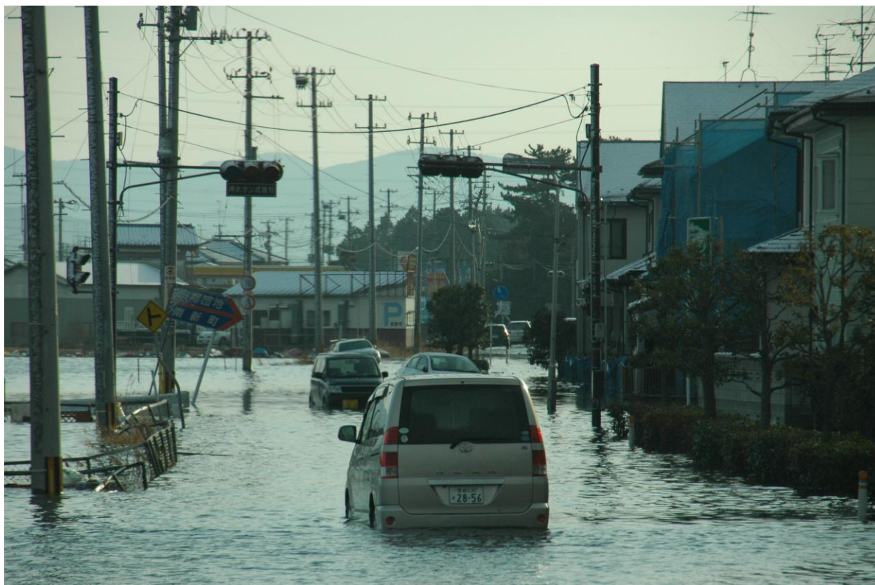
冠水した農免道路
