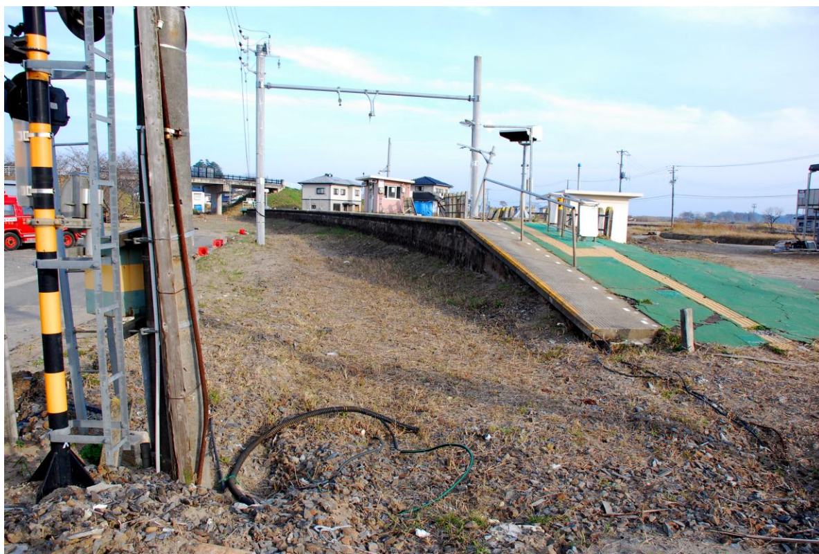
瓦礫と共に撤去された線路(東名駅)
